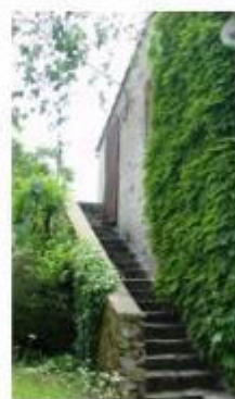
Escalier extérieur à la Ville Bessac
