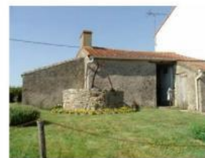
Abri et puits de la Pichonnière
