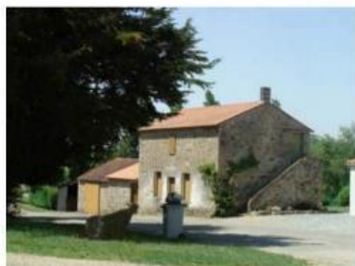
Ancienne maison d'habitation à la Massonnais, et son escalier extérieur
