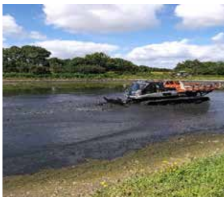
Curage des lagunes par engin à chenilles. Boues envoyées vers caisson de stockage.
