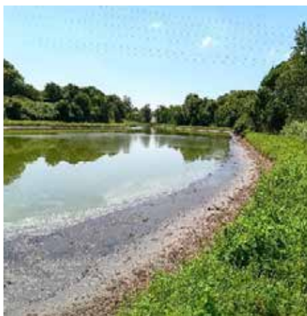
Evacuation des eaux surnageante par pompage pour accès aux boues décantées.
