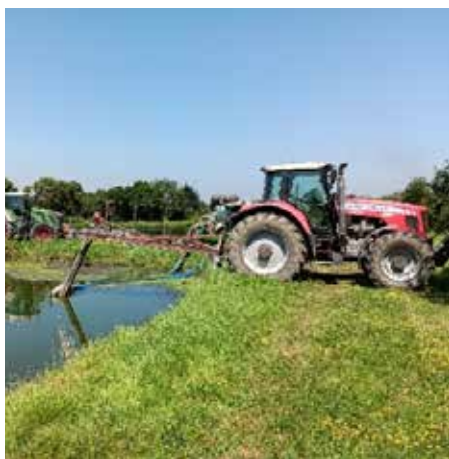
Evacuation des eaux surnageante par pompage pour accès aux boues décantées.
